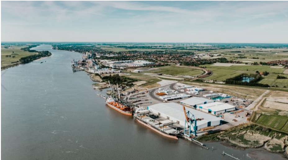
J. MÜLLER Weser in Brake, Schwerlastterminal Niedersachsenkai, Foto: Skypic Media, Bildbearbeitung Jana Weber Photography/ J. MÜLLER
