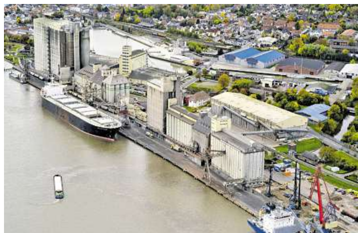
Ein Teil des Braker Hafens, der deutlich die Handschrift eines Unternehmens trägt, das auf eine 200-jährige Tradition zurückblicken kann: Der Logistikdienstleister J. Müller, der dort unter anderem Siloanlagen an der Pier betreibt.
